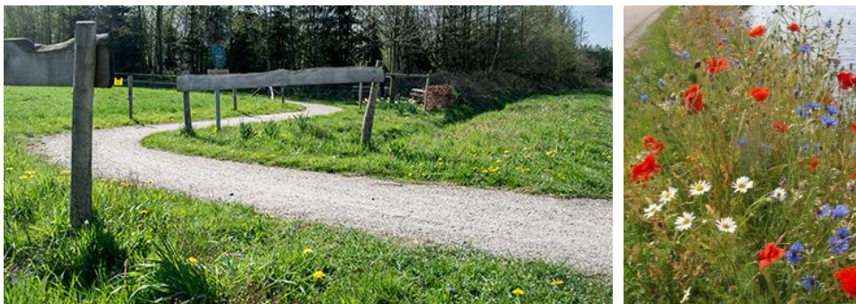
Figuur 1: Halfverhard wandelpad 1m breed met ingezaaide berm (inheems bloemenmengsel)
