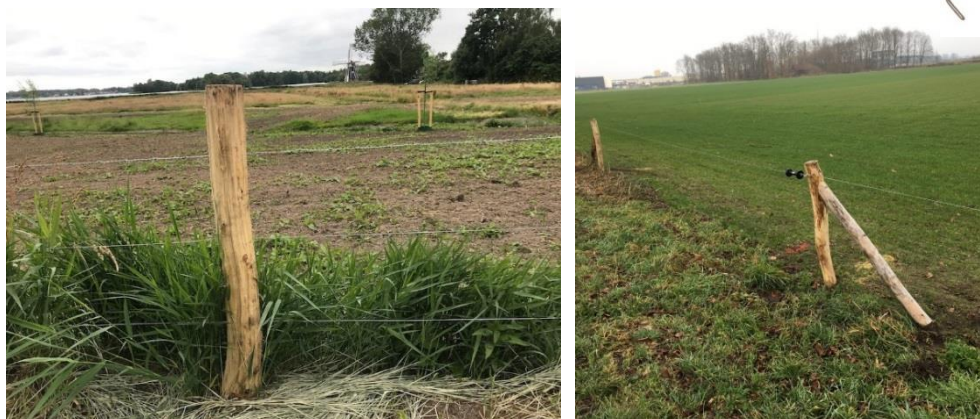
Figuur 2: Afrastering bestaande uit onbehandelde kastanje palen met 3 draden
